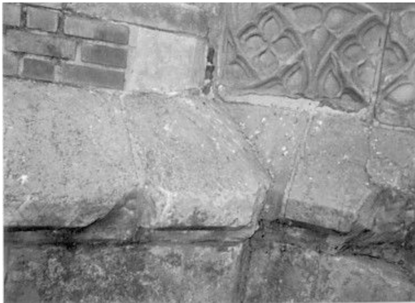
Fig.17. Zidul vestie al pridvorului actual adosat fațadei sudice a bisericii
