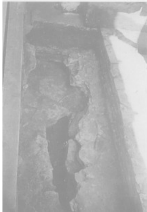
Fig.23. Caseta 14, pridvor, vedere de la sud asupra relației dintre fundația pridvorului inițial (stânga) și cea a pridvorului actual
