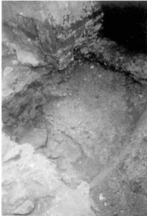
Fig.28. Relația între fundația stâlpului sud-estic al pridvorului actual și fundația re-zalitată, pe care o suprapune
