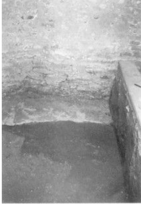
Fig.8. Caseta 15: regimul de fundare, la interior, în zona vestică a pronaosului
