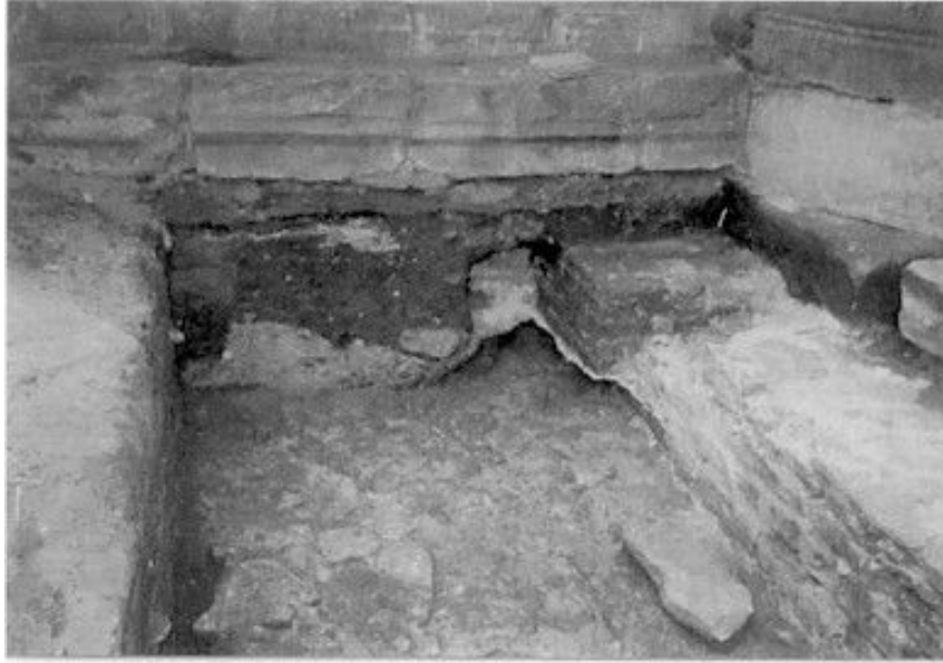
Fig.27. Banca zidului vestic al pridvorului actual (văzut de la est), cu suprapunerea nivelării ce acoperă decroșul fundației zidului sudic al bisericii și fundația
