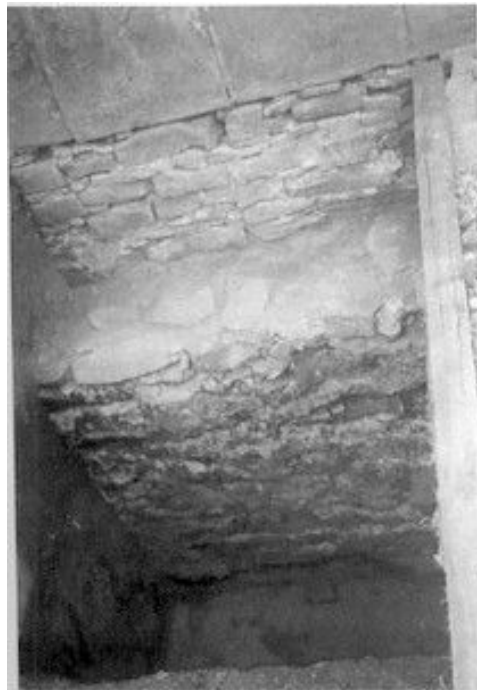
Fig.5. Caseta 13, regimul de fundare al zidului nordic
